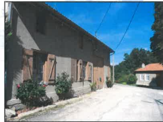
Constructions implantées sur limite d'emprise Source TOPOS
