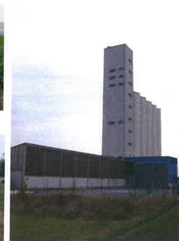
Silo Vivescia au bord de la RD 20
