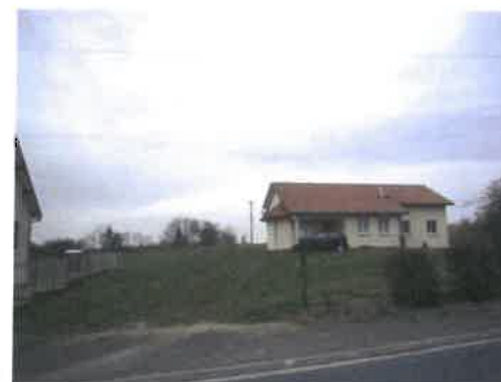
Construction récente en dent creuse
