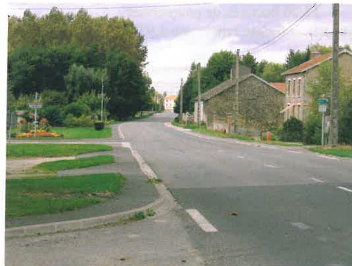
Entrée sud-est de la RD931
