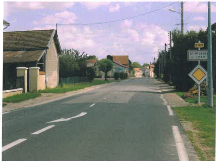
Entrée nord-ouest de la RD931
