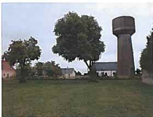
Espace vert et pâturages autour du château d'eau
