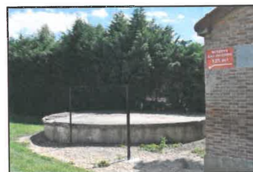
Réserve incendie Source TOPOS
