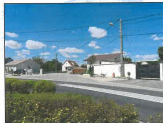
Constructions le long de la rue Gaston LOPPIN Source TOPOS
