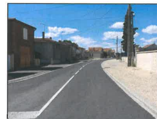
Voirie principale remise à neuf Source TOPOS
