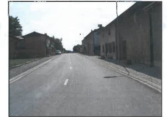
Constructions implantées sur limite d'emprise, rue de Vitry Source TOPOS
