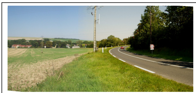
RD 980 ; entrée ouest de Pontfaverger
