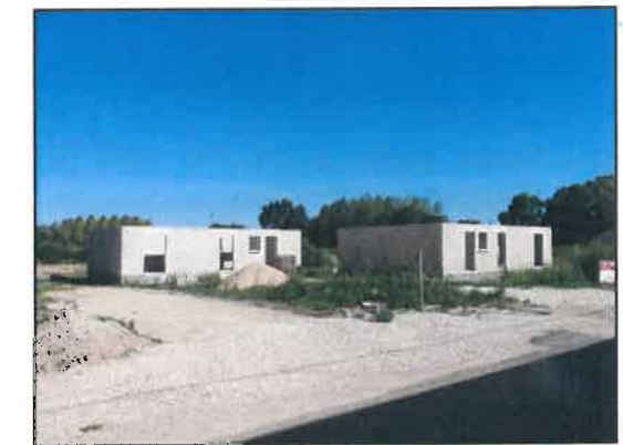
Pavillons en construction, au Nord de l'espace bâti Source TOPOS
