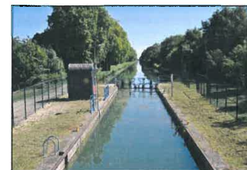
Ecluse de la commune
