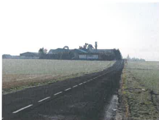
L'usine de déshydratation
