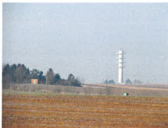
La tour de télécommunications
