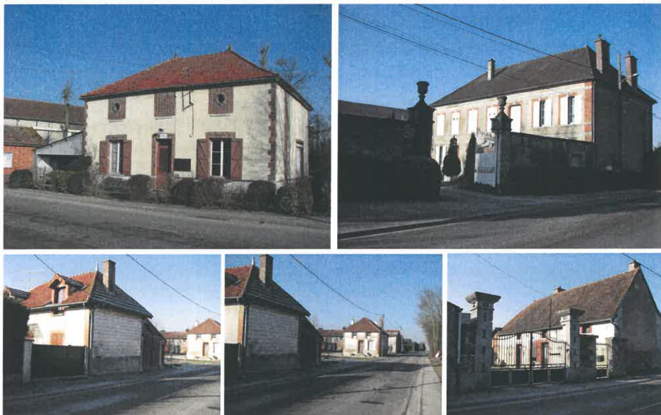
Le bâti ancien (ferme, habitation, mairie)
