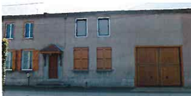
Rue du Canal, ancien corps de ferme de bourg réhabilité
