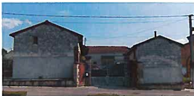
Grand'rue, cour de ferme en forme de "U"
