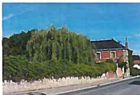
Mur de clôture plein, n°42 Grand rue
