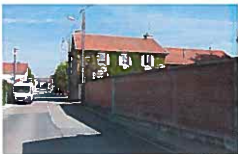
Mur de clôture plein, n°37 Grand rue
