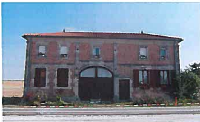
Corps de ferme, le long de la R.D. 1
