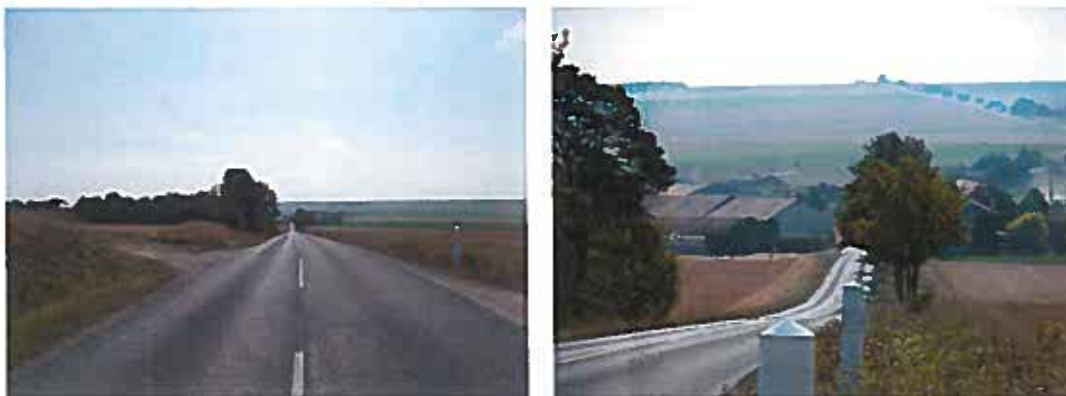
Entrée de ville de Châlons vers Longevas
