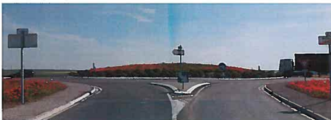
Giratoire de Moncetz-Longevas vu depuis la rue de la Creusotte
