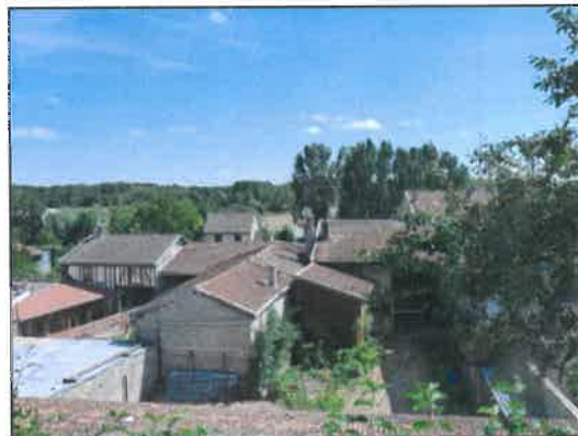
Vue depuis la Rue de la Mairie Source TOPOS
