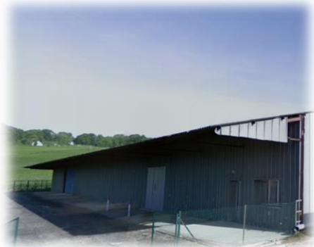
Figure 37 : Chemin de la Scierie à Merfy - Source : AUDRR
