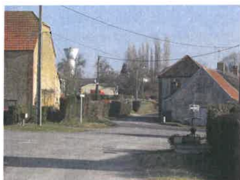
Le château d'eau
