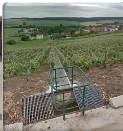
EXEMPLES d'aménagement d'un ouvrage avaloir avec garde-corps (Marne)
