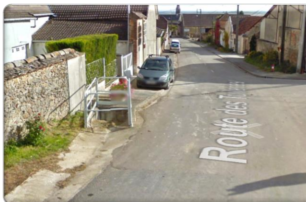
EXEMPLES d'aménagement d'un ouvrage avaloir avec garde-corps (Marne)
