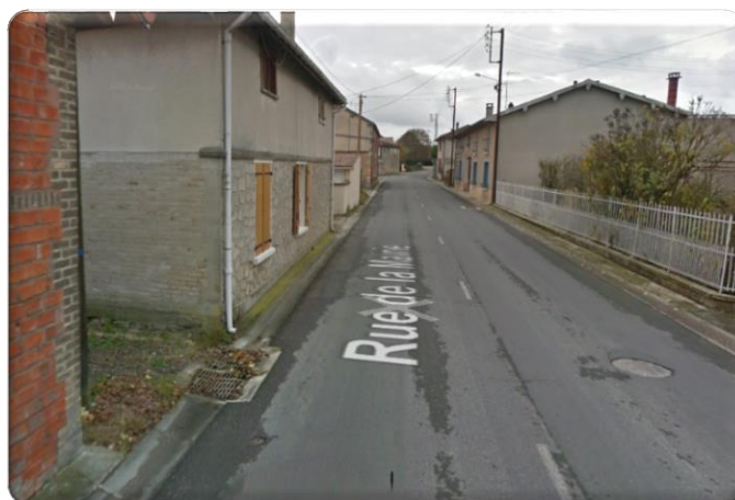
Ouvrage existant rue de la Mairie : double grille avaloir
