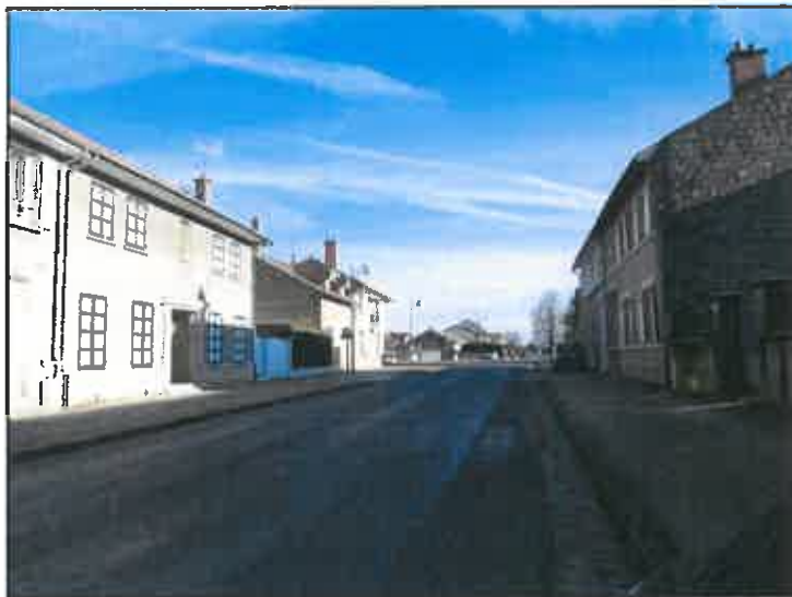
Bâti ancien, rue Principale Source : TOPOS
