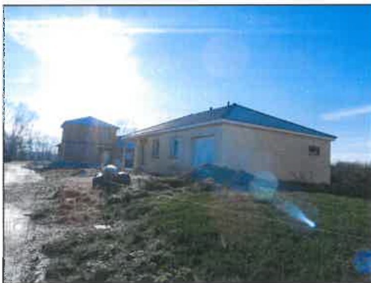
Construction récente, ruelle Brûlée Source : TOPOS
