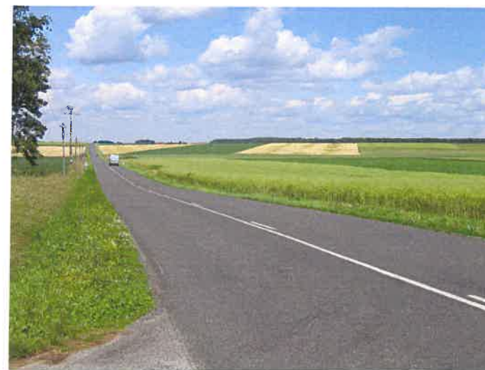
RD11 au carrefour avec la voie communale 3
