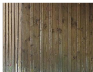
verticaux à couvre-joints
