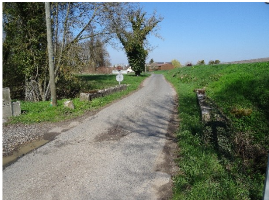
N°7 : Pont – La Boulonnerie
