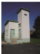
Captage AEP Puits 1 de Gueux
