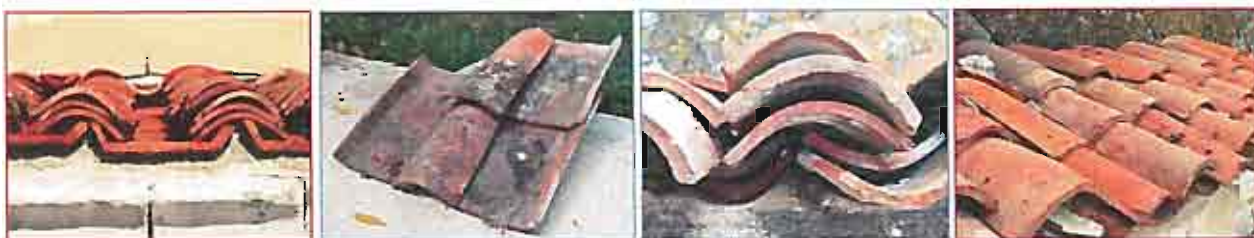
Vues ①② assemblage du type « romain » avec une imbrex (=plate) et une tegula Vues ③④ : couverture en tuile canal imbriquées, c'est le cas le plus fréquent.
