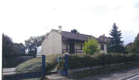
Pavillon des années 80 en extension
