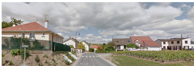
Pavillons à l'entrée Sud
