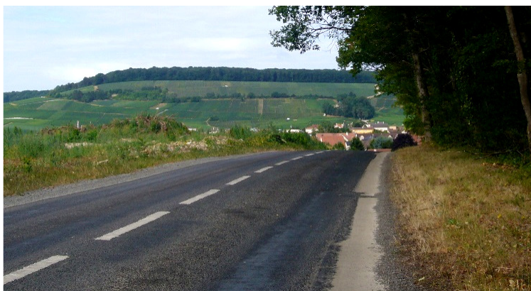
Rue de la Garenne, chemin communal reliant Villiers-aux-Nœuds
