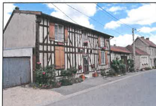
Maison rénovée, Grande Rue
