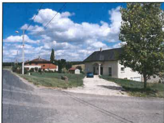
Extension pavillonnaire à l'Est de ROSAY
