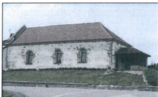
Ancienne église - Varimont
