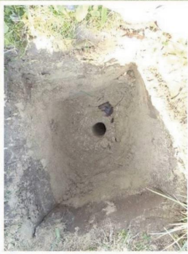
3. Fosse de 30 à 50 cm de profondeur réalisée à la bêche
