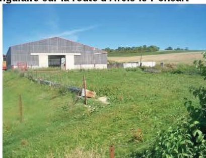
Surrévation en contre bas du bâtiment du chemin du Bon Martin (rehaussement de terre végétale)
