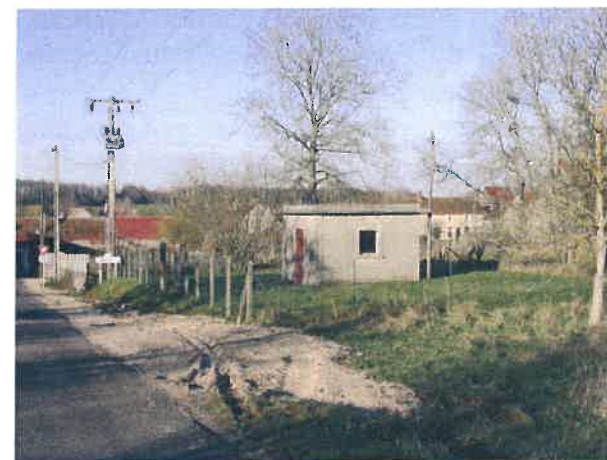
Le captage d'eau
