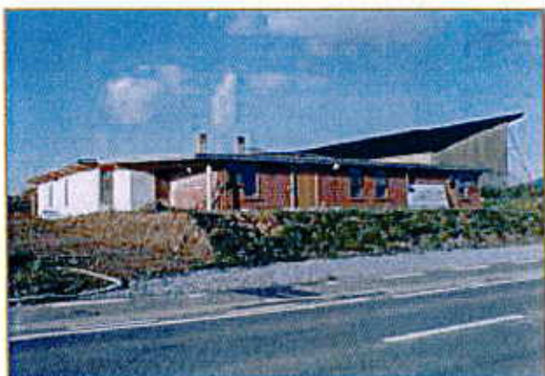
Le bâtiment de la boulangerie de la Ferme de la Croix a été réalisé selon les principes de l'écoconstruction.
