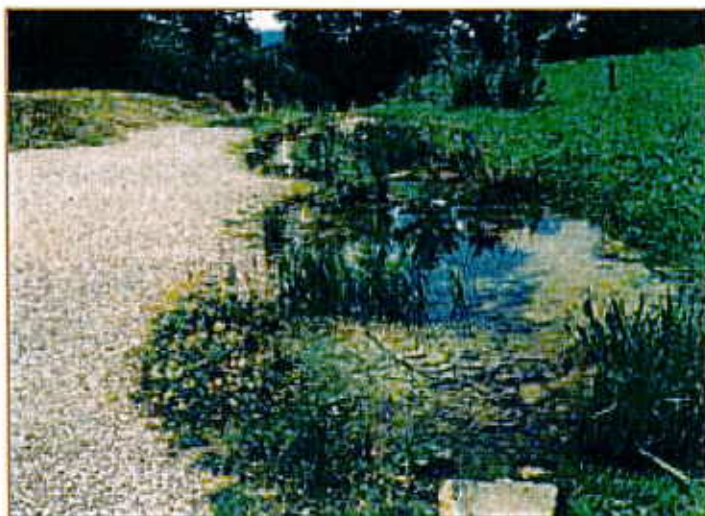
Installation d'un fossé d'infiltration dans une zone en cours d'équipement à Maastricht.
