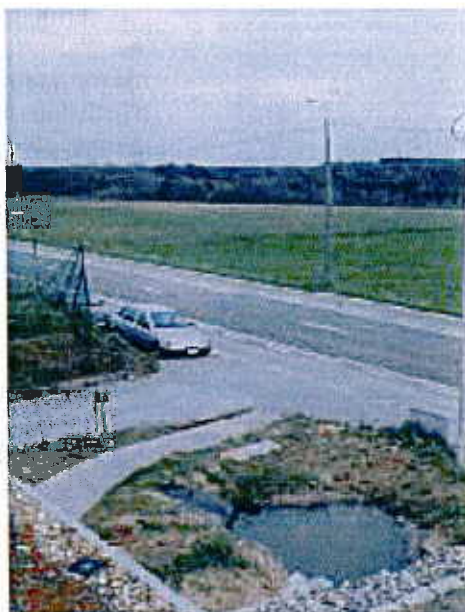
Le dernier bassin du système d'épuration des eaux a permis la création d'une mare qui est ici en cours d'aménagement final.
