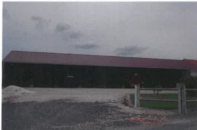
Bâtiment agricole Rue des Fosses
