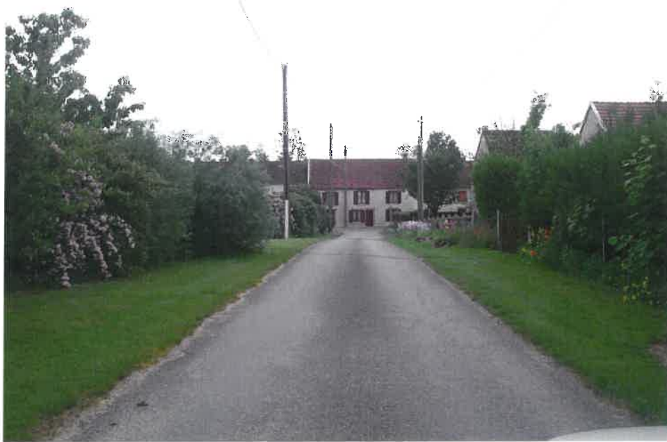
Rue du transformateur
