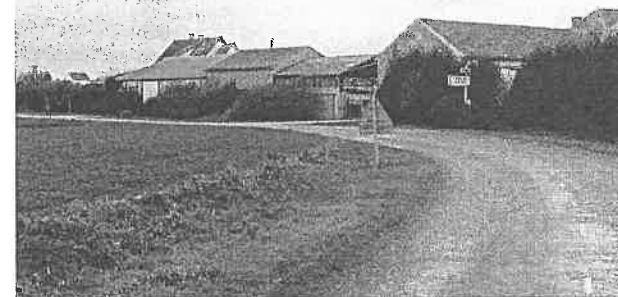
Entrée à Coizard par la RD43 au Sud Est
