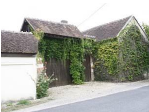
Porche d'entrée d'une cour en retrait de l'alignement
