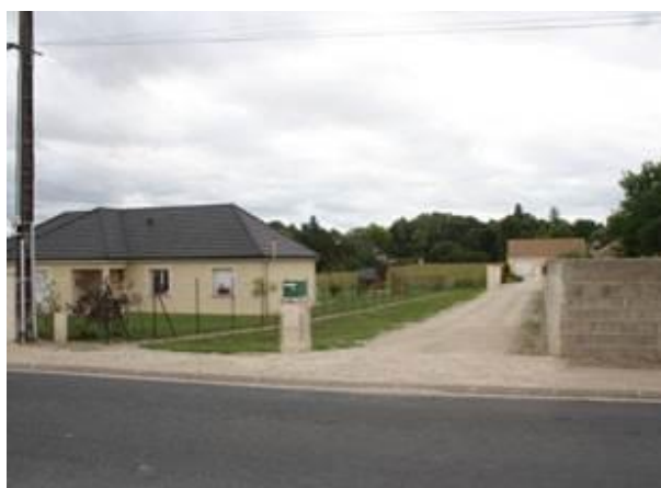
Constructions récentes en retrait de l'alignement et en doubles rideaux
