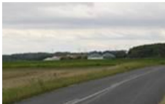
Vue sur l'ICPE d'élevage de porc et d'installation de méthanisation
