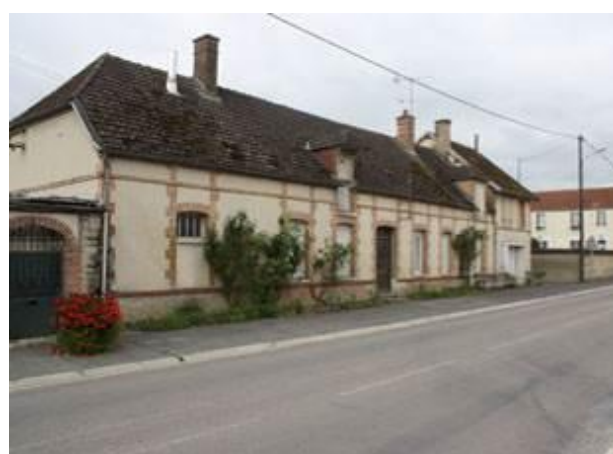
Construction ancienne avec chainages d'angles et encadrement de baies en brique
