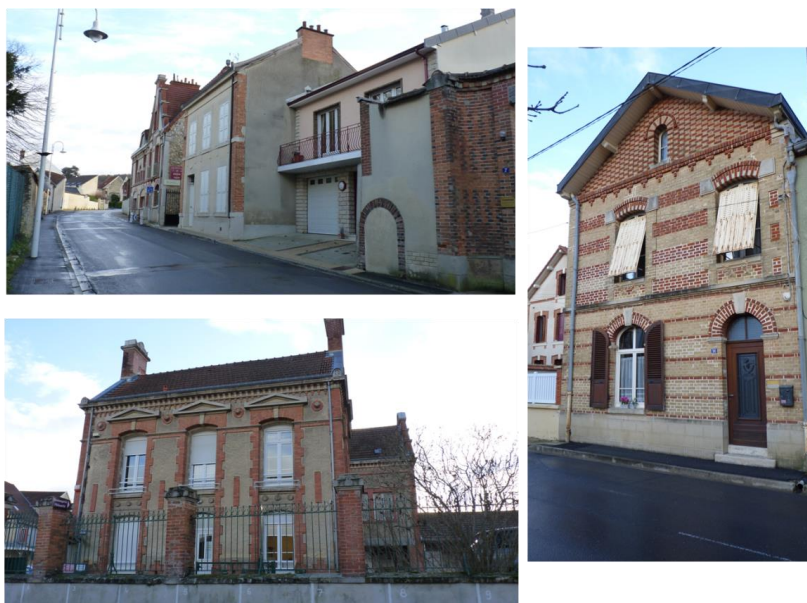
Utilisation de la brique rouge, et de la pierre enduit ton beige
