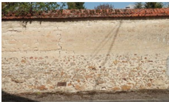
Mur en meulière et carreaux de terre
