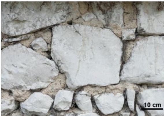
Moellons de craie maçonnés
