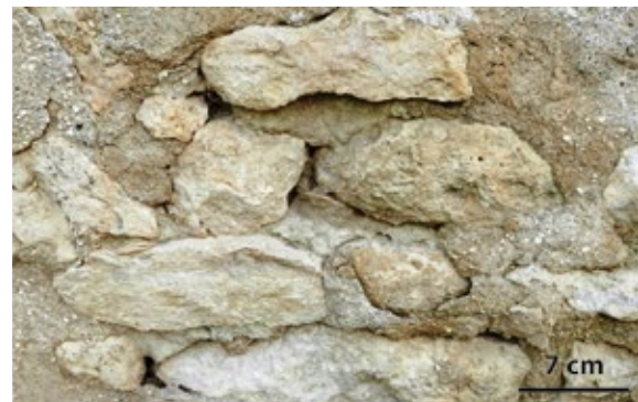
Construction en moellons calcaires, Jonquery
