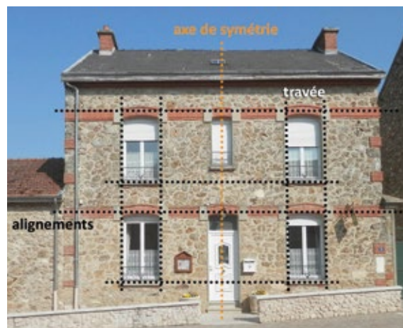
Organisation des ouvertures en façade
