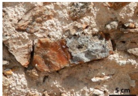
Meulière compacte en œuvre dans une maçonnerie
