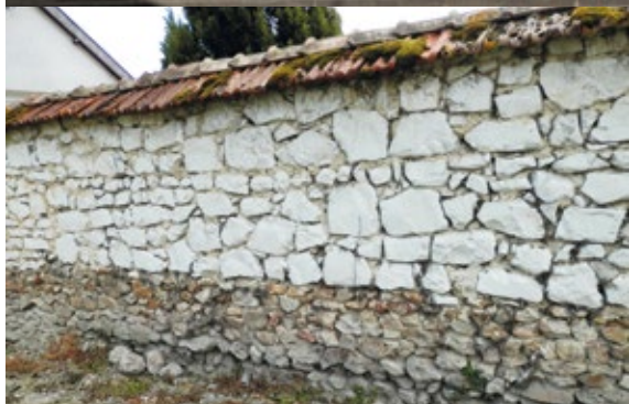
Mur en meulière et moellons de craie
