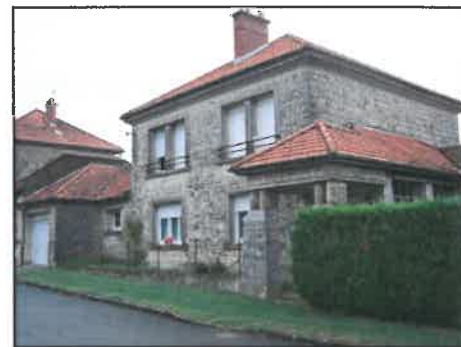
Une construction dans la commune Source TOPOS
