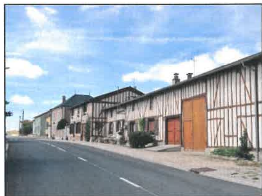
Rue de Vitry Source TOPOS
