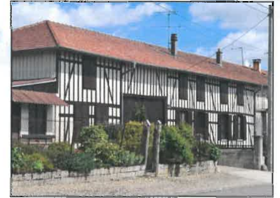
Maison rénovée, rue de Vitry Source TOPOS
