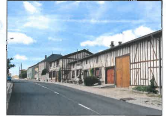
Rue de Vitry Source TOPOS
