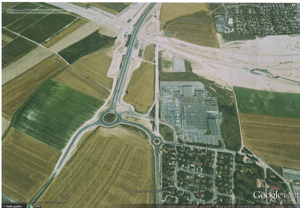
LGV et Autoroute A4 bis (déviation Sud de Reims) en travaux en 2004
