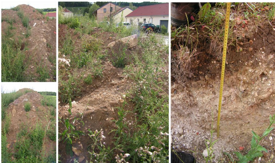
Vues des déblais de la fondation de la maison ci-dessus
