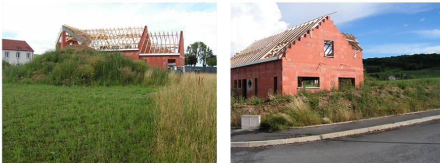
Maison construite sur la parcelle 174
