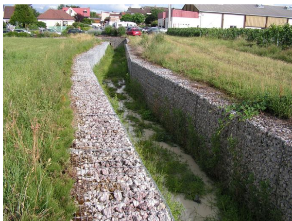
Vue du ruisseau du Rouillât en marge de la parcelle 179
