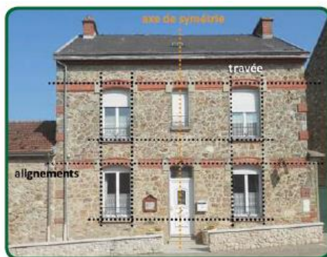
Organisation des ouvertures en façade.
