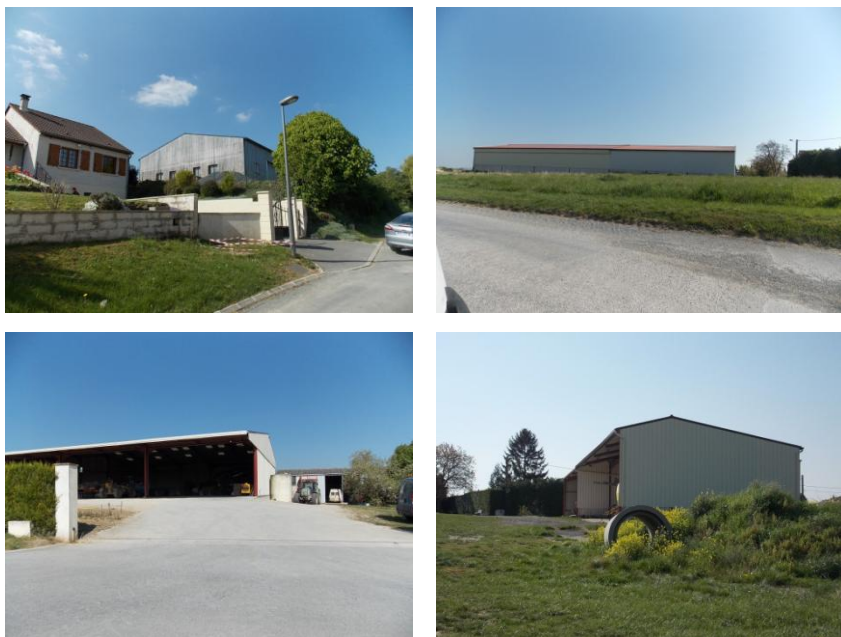
Exemples de bâtiments agricoles
