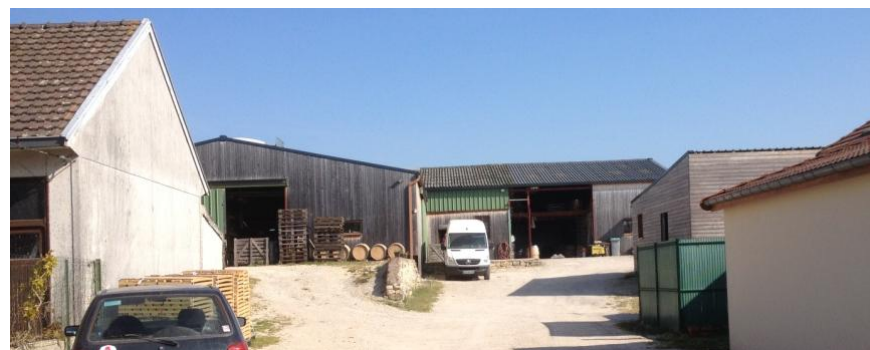
Tonnellerie, place de la mairie
