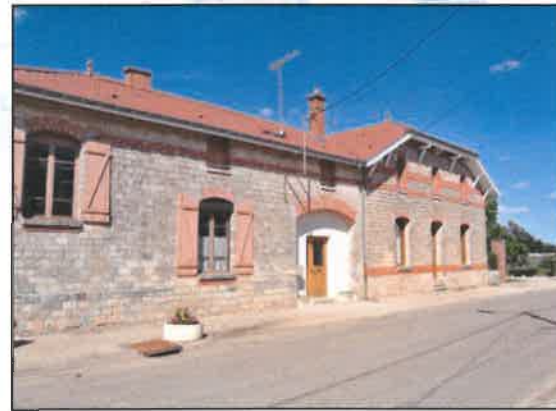
Ferme rénovée, rue de Favresse Source TOPOS
