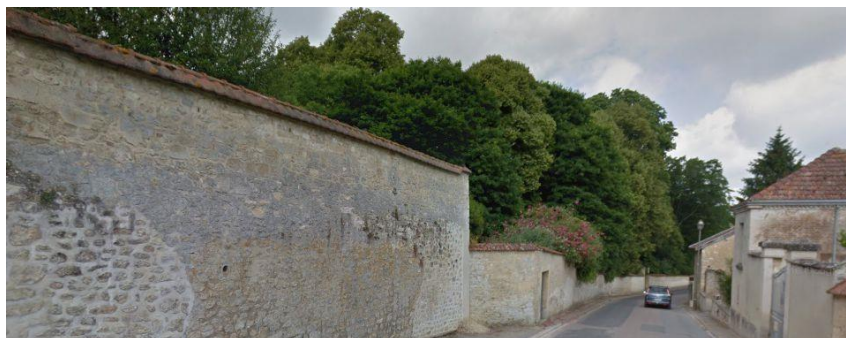
✓ Le mur d'enceinte (depuis la rue de la Haute Ville)
