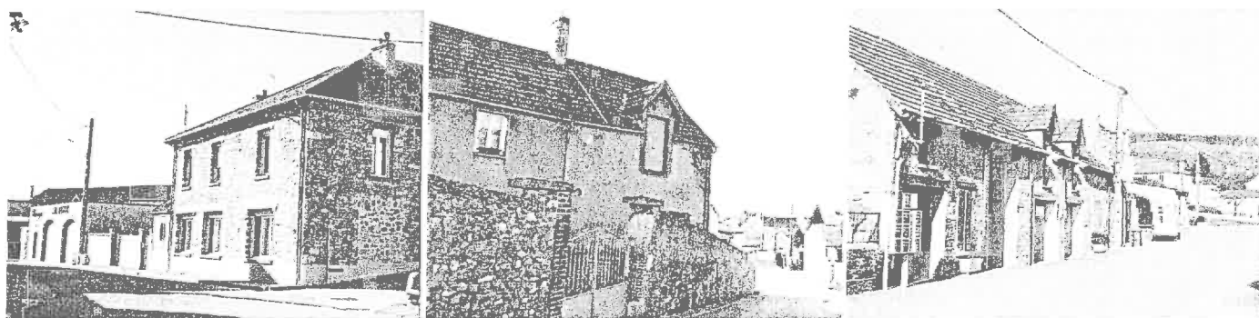
Le bâti ancien
