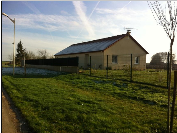
Construction récente, rue de la Vierge Source : TOPOS
