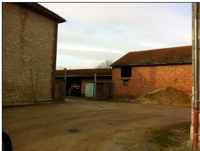
Bâti agricole rue Chauffour Source : TOPOS
