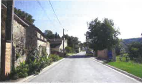
Constructions de part et d'autre de la RD 324
