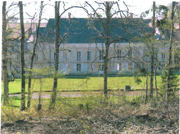
Façade Est du château de Baye
