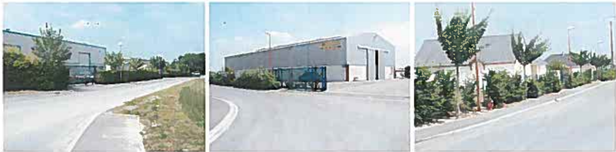
Le bâti de la zone d'activités de la Grande Carrière
