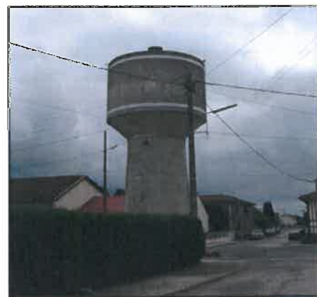
Château d'eau à ALLIANCELLES Source TOPOS
