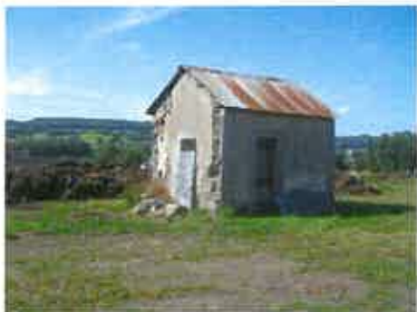
L'ancienne gare de Vernix
