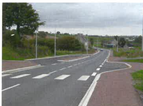
La RD 911 réaménagée
