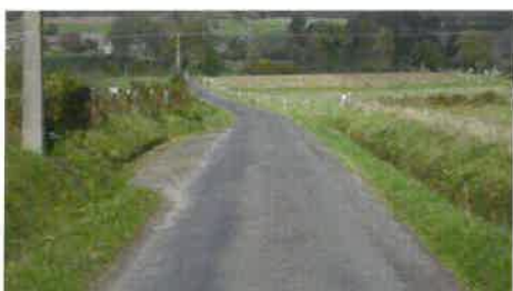
Dégagement sur la RD 162
