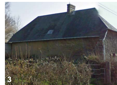
3. Façade aveugle au nord
